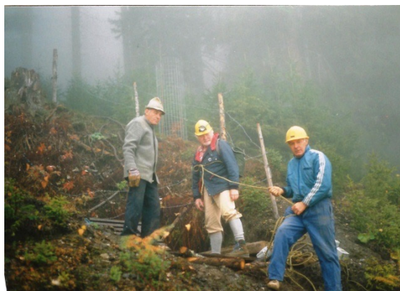
Sicherung des Schachtes am Hochglocker. Quelle: H.-W. Pelzmann.
